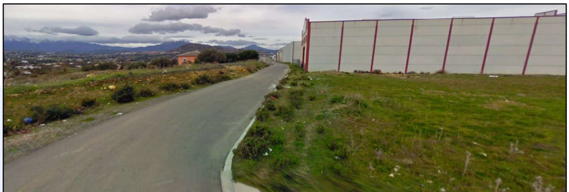
Vista del camino público existente en el límite oeste del sector
